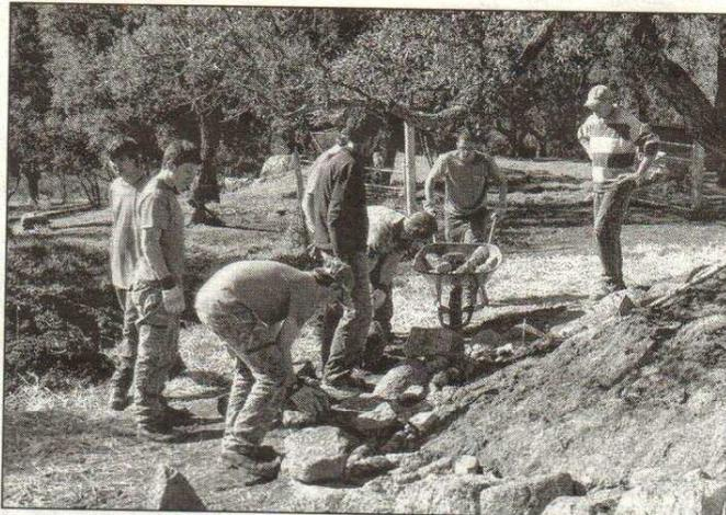
Construction d'un mur en pierre sèches dans le cadre du projet Accessit par les élèves du lycée agricole.
