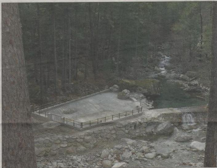
La prise d'eau de la Restonica sera complétée par un nouveau système installé sur la RN 200, avec huit forages et une canalisation de 3 500 mètres vers la ville.
